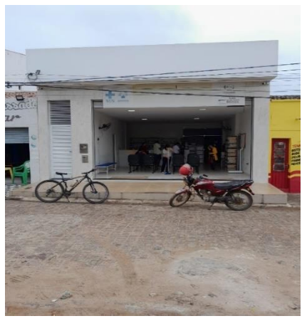
Foto 04 – Porta de Acesso à Farmácia Básica – Local de Distribuição de Medicamentos - Data 12/09/2023
