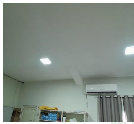
Foto 17 – Detalhes do Armazenamento dos medicamentos com relação ao teto e a refrigeração (ar condicionado) no CAF - Data 12/09/2023
