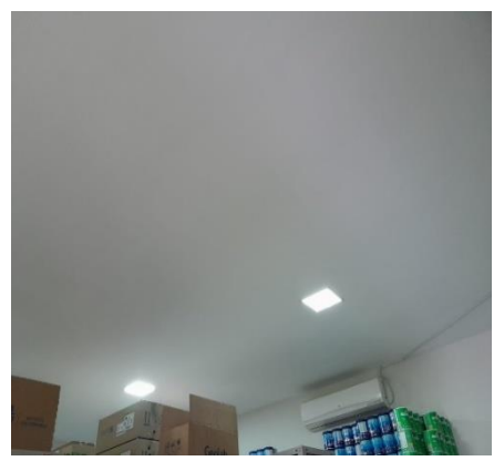
Foto 16 – Detalhes do Armazenamento dos medicamentos com relação ao teto e a refrigeração (ar condicionado) no CAF - Data 12/09/2023
