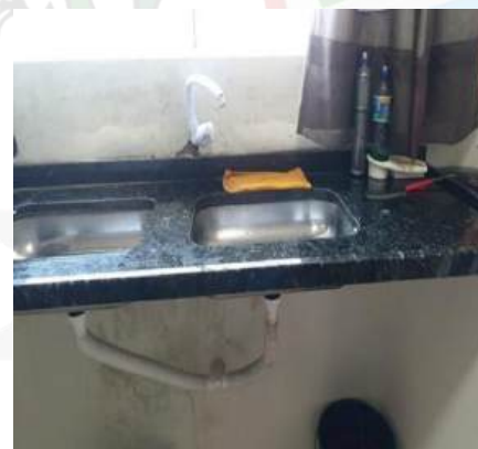
Foto 03 – Detalhes de vazamento na pia de higienização no CAF Data 12/09/2023
