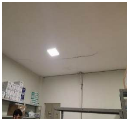
Foto 01 – Detalhes de rachadura e infiltração no gesso do teto no Cômulo de armazenamento dos descartáveis no CAF - Data 12/09/2023
