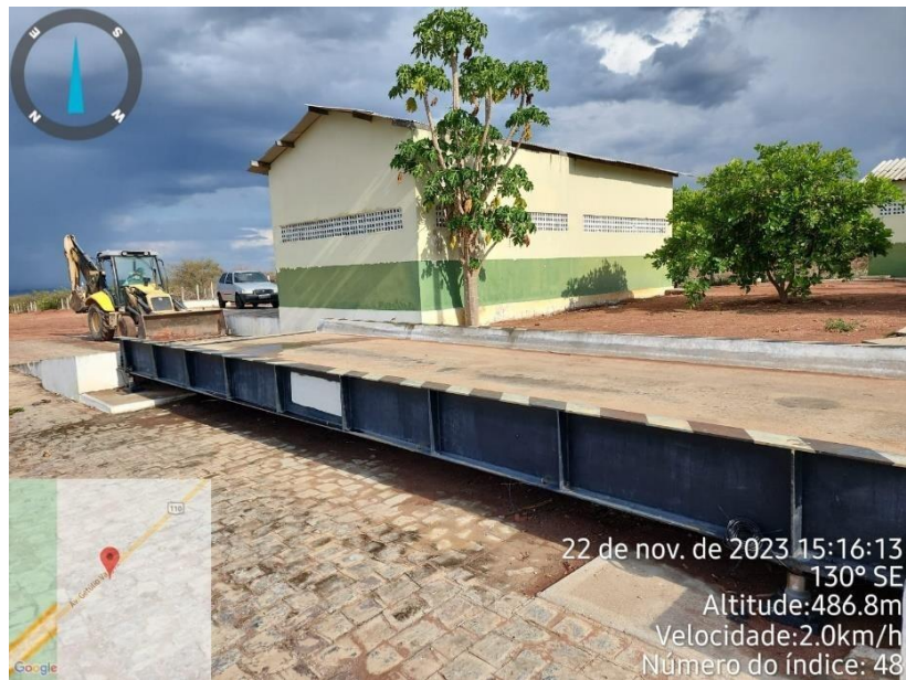
Figura 4. Foto da balança rodoviária com edificação ao fundo
