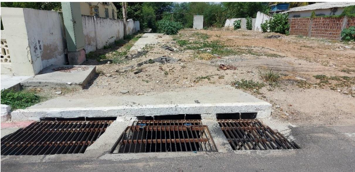
**Figura 53 – Boca de Lobo Tripla Próxima a Lote Vago com Ausência de Cobertura Vegetal**
