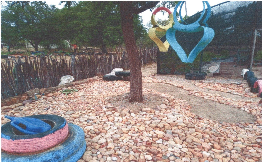
Figura 15: Construção de um novo jardim
